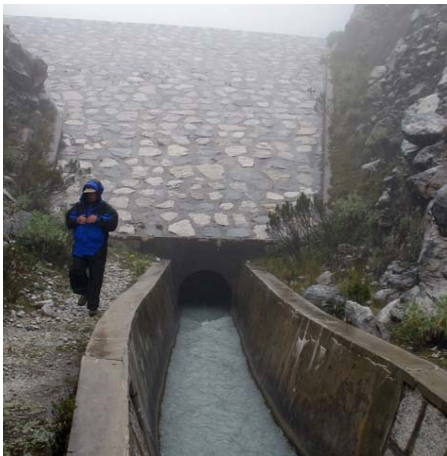
Рис. 9. Дамба и водосборос на озере Льяка (хребет Кордильера-Бланка, Перу, фото Д.А. Петракова)
