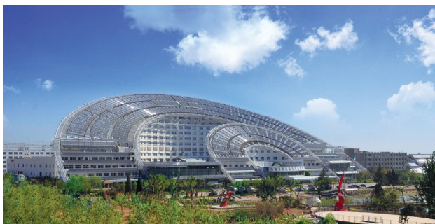
Рис. 2. Офисное здание "Sundail" в городе Дэчжоу, провинция Шаньдун [4]
