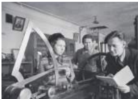
Фото: «Студенты второго курса металлургического института имени Сталина за испытанием на разрыв металлического стержня. Днепрпетровск» (1944)
