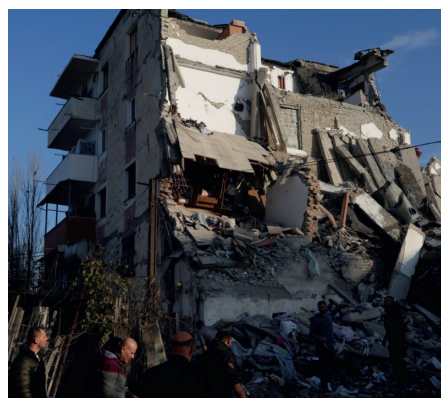
Разрушенное здание (Florian Goga / Reuters)
