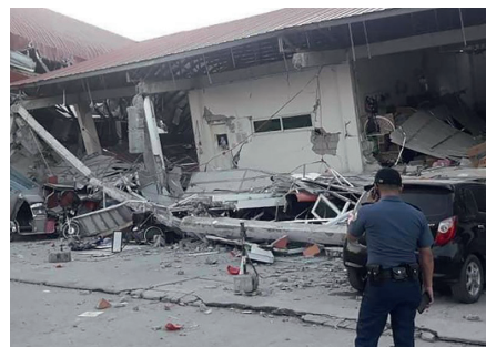
Последствия землетрясения ( https://24tv.ua )
